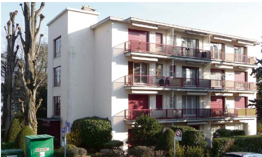
Photo avant travaux
